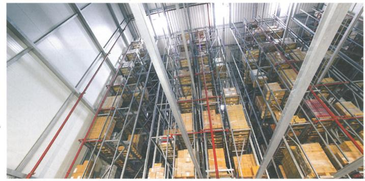
**Hochregallager:** Beim Betzold Verlag für Lehrmittel & Schulbedarf in Ellwangen erforderte das Gebäude eine spezielle Sicherheitstechnik. Da sich aufgrund der Raumhöhe keine herkömmlichen Brandmelder einbauen ließen, wurde ein modernes Rauchansaugsystem installiert.
